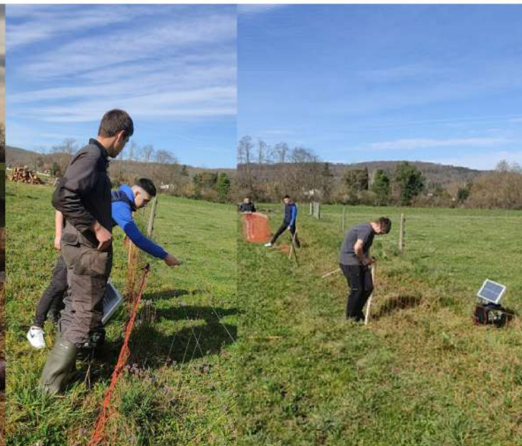
installation de la clôture
