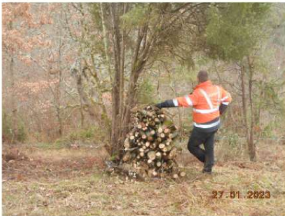
prof surveillant le chantier
